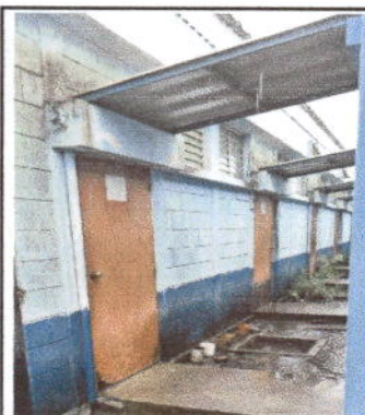
Foto 3: Módulo 1, aulas 1, 2 y 3. Sustrucción de puertas de madera por metal.
