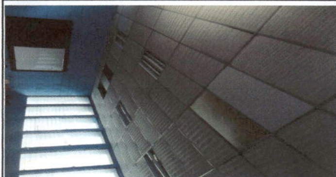
Foto 25: Módulo de aulas 1, 2, 3: sustitución se lámparas y planchas de demoport
