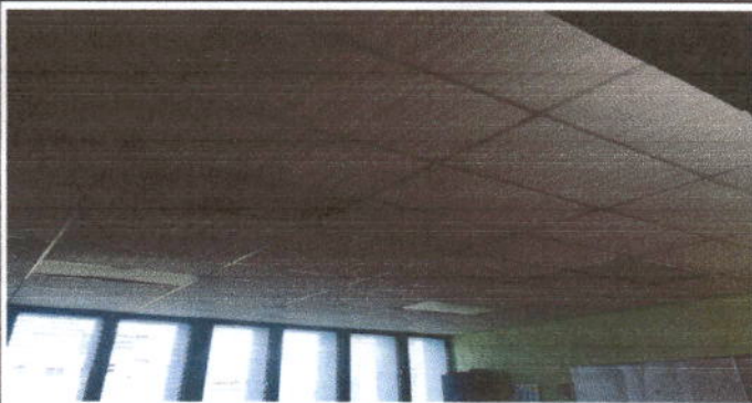
Foto 21: Módulo de aulas 1, 2, 3: sustitución se lámparas y planchas de demoport
