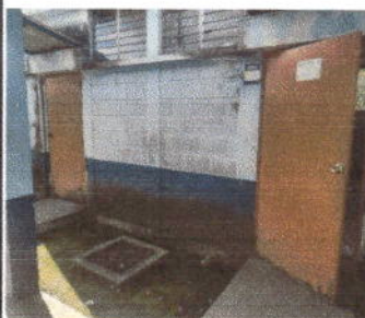
Foto 5: Módulo 1, aula 4 y 5. Sustrucción de puertas de madera por metal.
