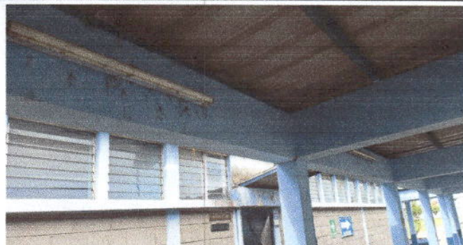
Foto 14: Pasillo 3 y 4 sustitución de lámparas led
