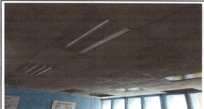
Foto 22: Módulo de aulas 1, 2, 3: sustitución se lámparas y planchas de demoport
