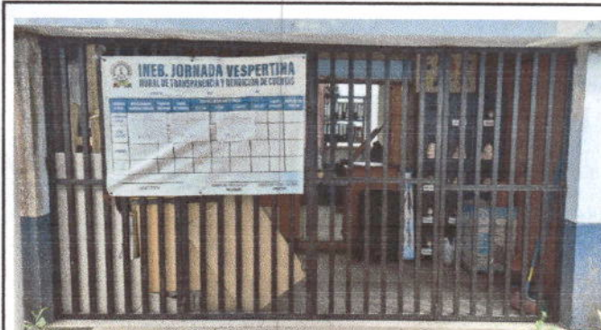
Foto 2: Módulo de Dirección: Mantenimiento a portón de metal.
