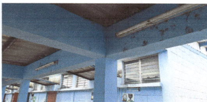
Foto 9: Aulas módulos 2 sustitución de lámparas y planchas de demoport
