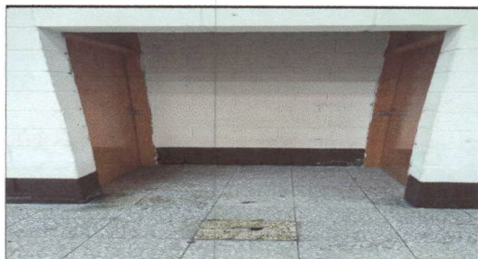
Foto 12: Sustitución de puertas de madera por puertas de metal en el Salón de Actos
