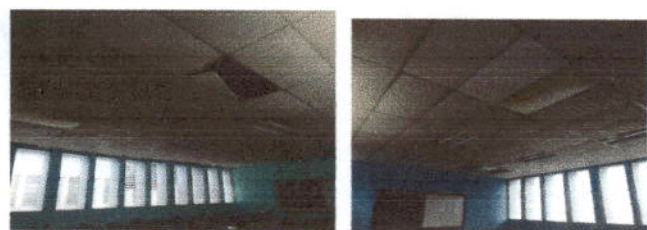
Foto 11: Módulo de aulas 1, 2, 3: sustitución se lámparas y planchas de demoport
