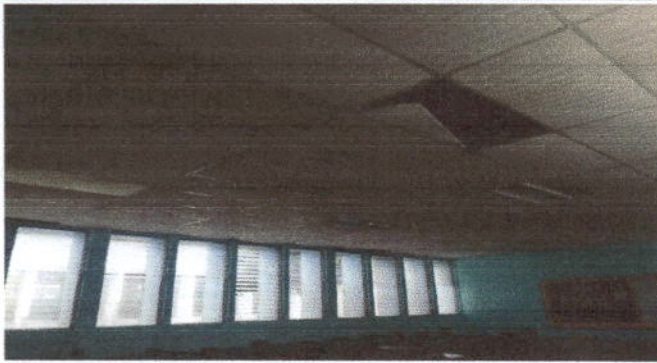
Foto 19: Módulo de aulas 1, 2, 3: sustitución se lámparas y planchas de demoport
