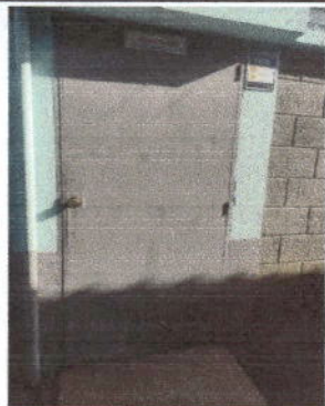
Foto1: Módulo 3 aula 1. Sustrucción de puertas de madera por metal y una sustrucción de puerta de madera por metal de una aula.
