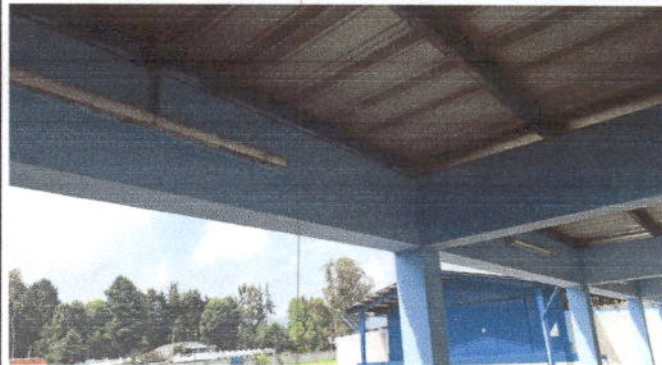
Foto 10: Módulos Pasillo 2 Sustitución de lámparas led
