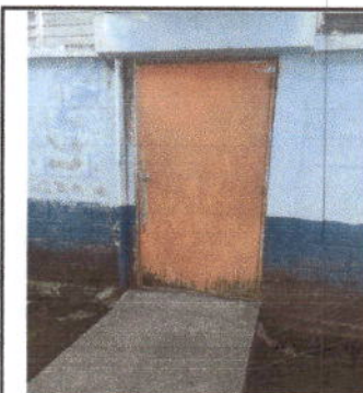
Foto 6: Módulo 2, aula 7. Sustrucción de puertas de madera por metal.
