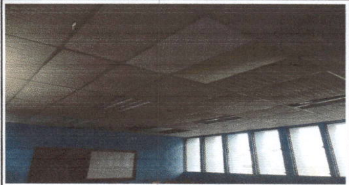
Foto 20: Módulo de aulas 1, 2, 3: sustitución se lámparas y planchas de demoport
