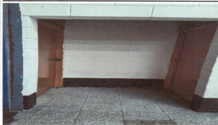
Foto 29: Sustitución de puertas de madera por puertas de metal en el Salón de Actos.
