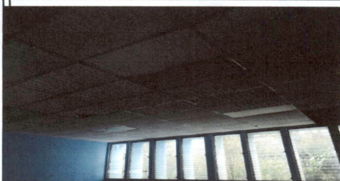
Foto 27: Módulo de aulas 1, 2, 3: sustitución se lámparas y planchas de demoport
