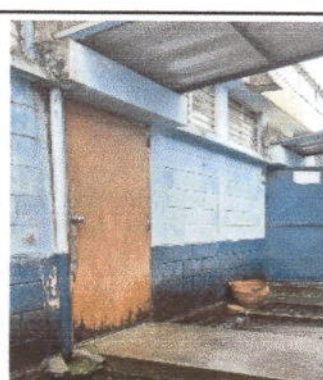
Foto 4: Módulo 2, aulas 4, 5, 6, 7 y 8. Sustrucción de puertas de madera por metal.
