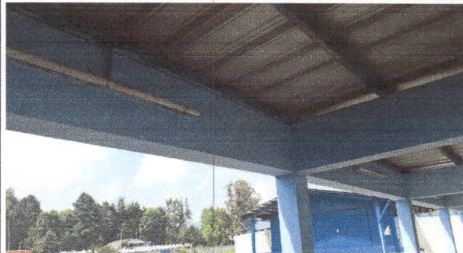
Foto 16: Módulos 1, 2 y 3 sustitución de lámparas y planchas de duroport 2 x 4
