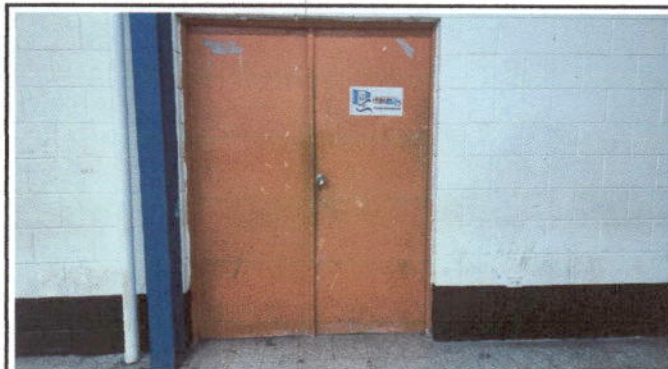
Foto 28: Sustitución de Portón de doble hoja en el módulo del Salón de Actos.
