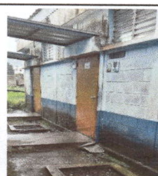
Foto 6: Módulo 2, aula 7. Sustrucción de puertas de madera por metal.
