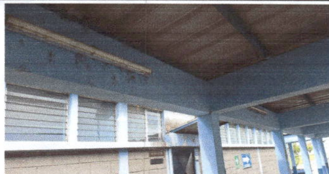
Foto 8: Pasillo 3 y 4 sustitución de lámparas led
