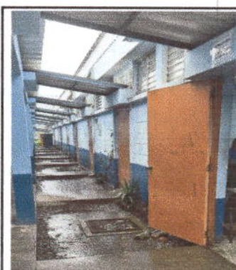
Foto 4: Módulo 2, aulas 4, 5, 6, 7 y 8. Sustrucción de puertas de madera por metal.
