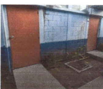
Foto 5: Módulo 1, aula 4 y 5. Sustrucción de puertas de madera por metal.
